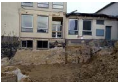
Während der Sanierung
