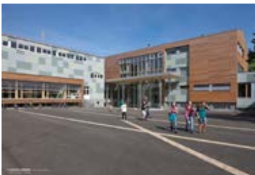
NMS Neumarkt nach der Sanierung
