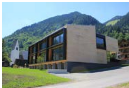
Außenansicht des Schulbaues in Passivhausqualität
