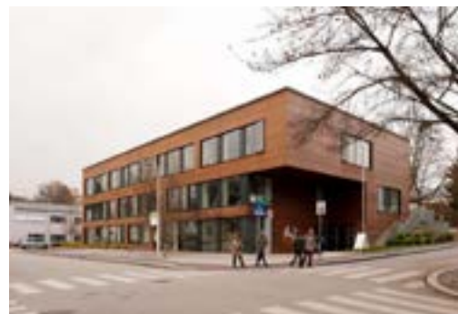
... und nach der Fertigstellung
