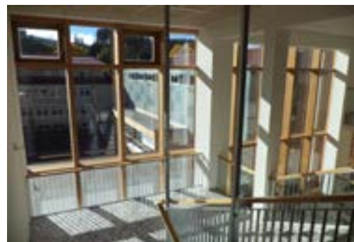
Die zusätzliche Nachtlüftung durch Stiegenhausfenster erhöht den durch Lüftungsklappen erzielten Effekt
