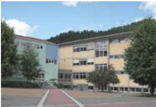
NMS Neumarkt vor der Sanierung
