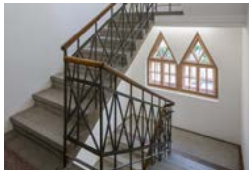
Erhaltung aller Details auch bei der Erschließung
